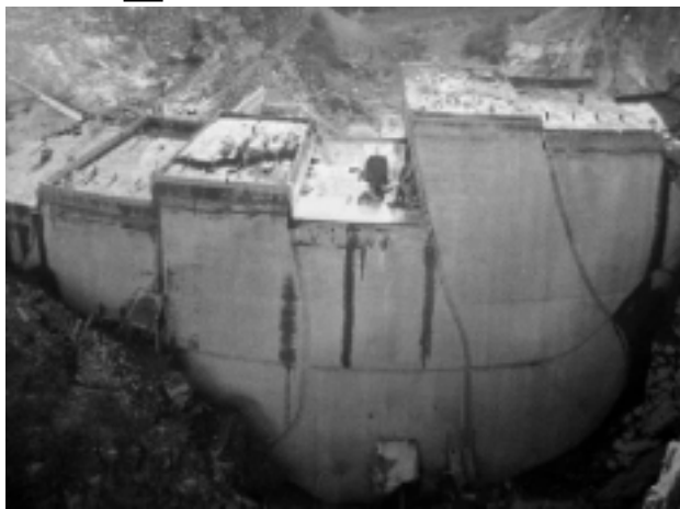
I lavori per la costruzione della diga di Fortebuso nel 1952
