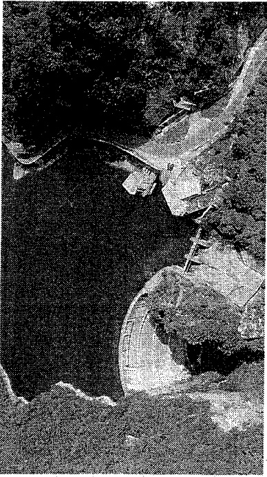
La diga di Val Schener, gestita da Primiero Energia
